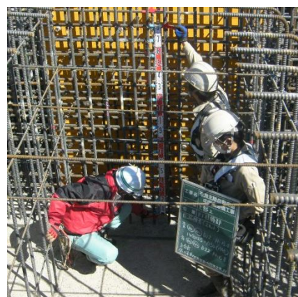
【従来の配筋検査】
